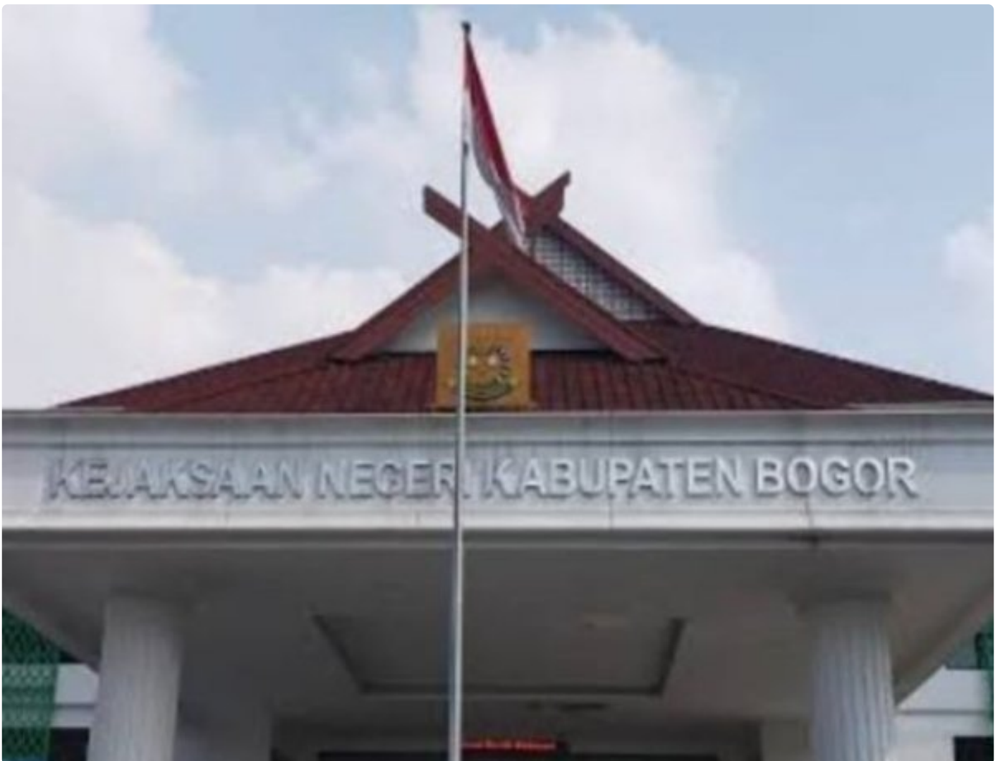
Photo : Gedung Kejari Kabupaten Bogor
